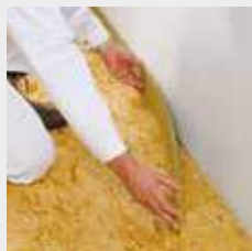
Lägg ut kantisoleringen och håll samman ändarna i hörnen
