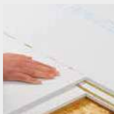
Limning av golvelementen med helt fyllda stödskarvar
