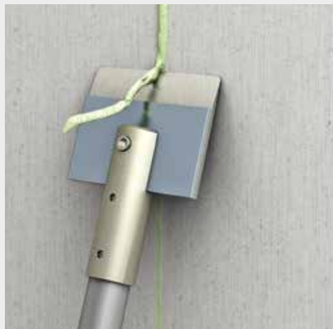
Nästa dag avlägsnas överskjutande limfog
