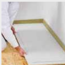
Montering av fermacell Golvelement
