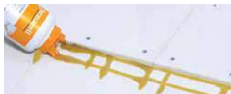
Limsträng på kanten till plattan
