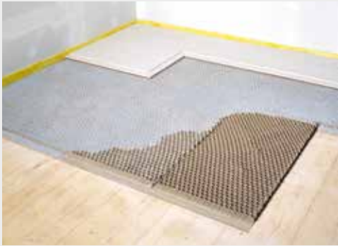
Golvuppgbyggnad i husets våtrum
