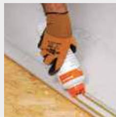
fermacell Fibergips golvelementlim påförs i falsen
