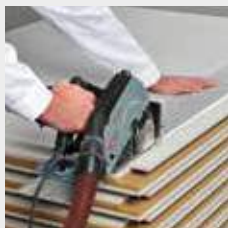
Avsågning av falsen vid första raden
