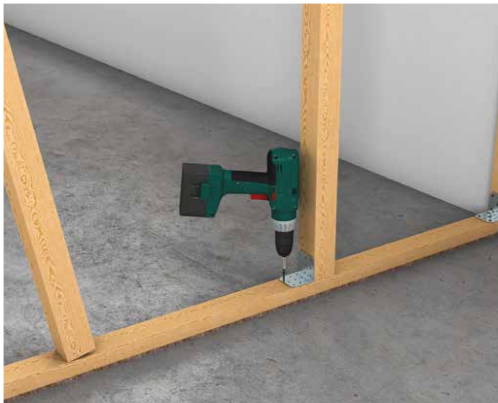
Montering av underkonstruktion av trä.
