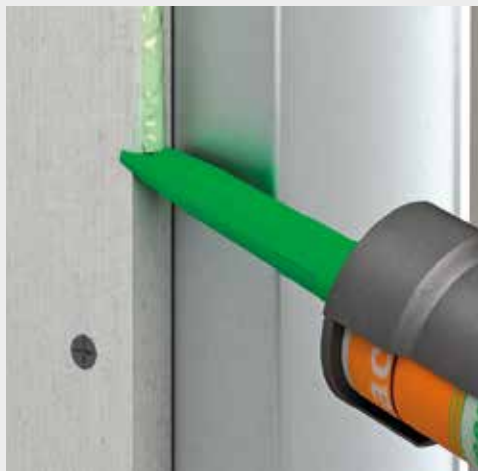
Påför fermacell Limfog mitt på skivans kant
