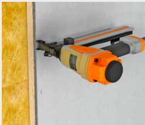
Häfta eller skruva fast skivan på underkonstruktionen.
