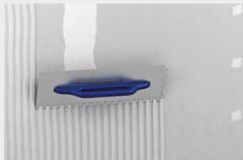
Figur 1: Påföring av fermacell lättbruk med 12 mm tandspackel
