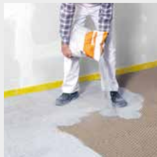
Uthållning av fermacell Bikupegranulat
