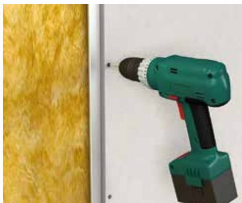
1 Skruva fast – eller montera med klammerpistol
